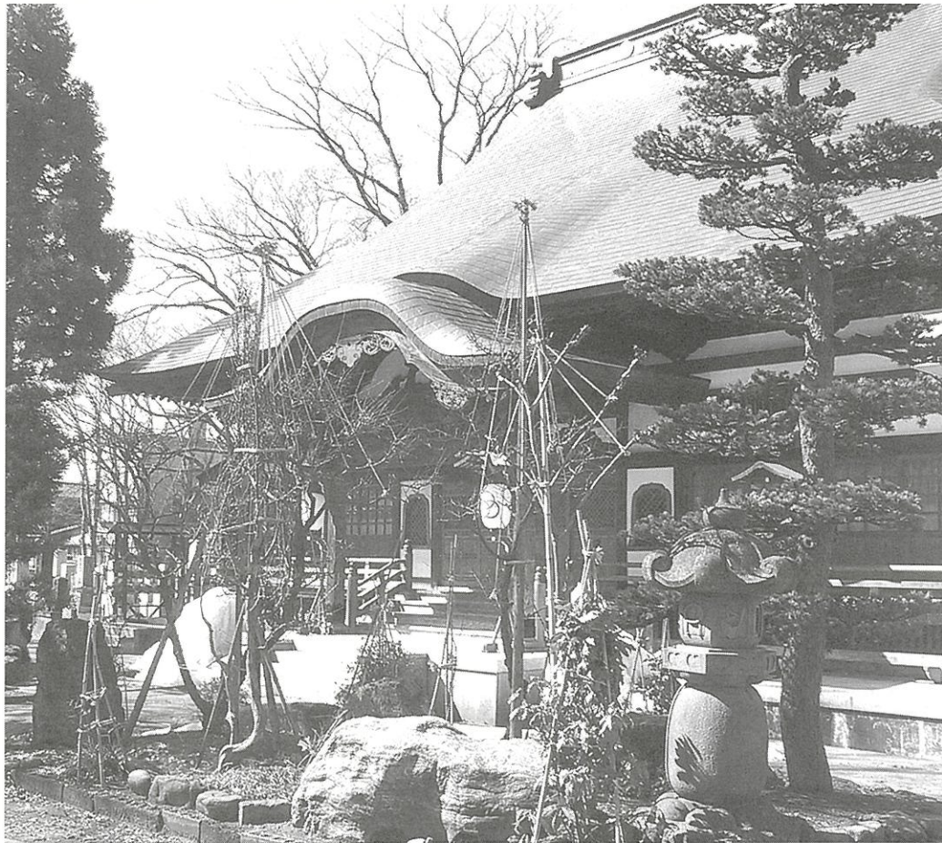
残雪の残る春の訪れを待つ安善寺本堂
