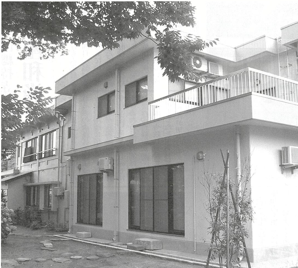
完成した客殿の外観
