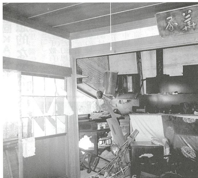
常福寺仮本堂の内部
