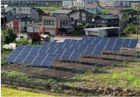
地上設置の全量売電型の太陽光発電所
