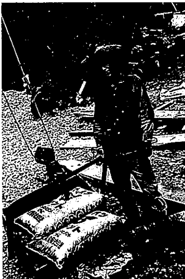
土木工事のアルバイト
