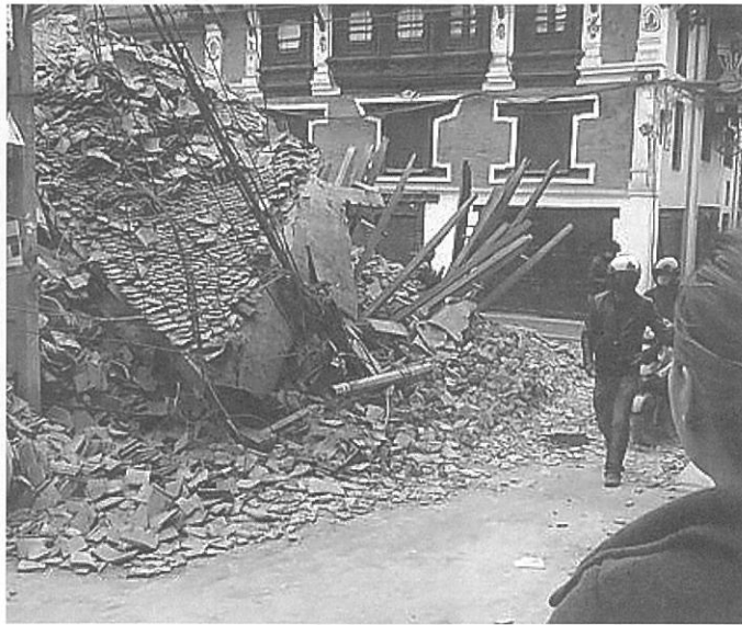
地震で崩れた世界遺産パタンの寺院
